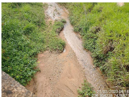
Foto 3 – Sedimentos aluvionares na drenagem do ponto 5. (Data: 21/02/2023).
